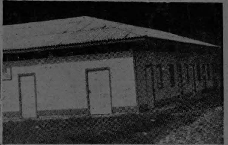
Este es el edificio que ocupa en Villa Neily, la Sucursal del Banco Nacional de Costa Rica, cuyas actividades son aprovechadas por los trabajadores de algunas de las fincas bananeras del valle del río Coto.
