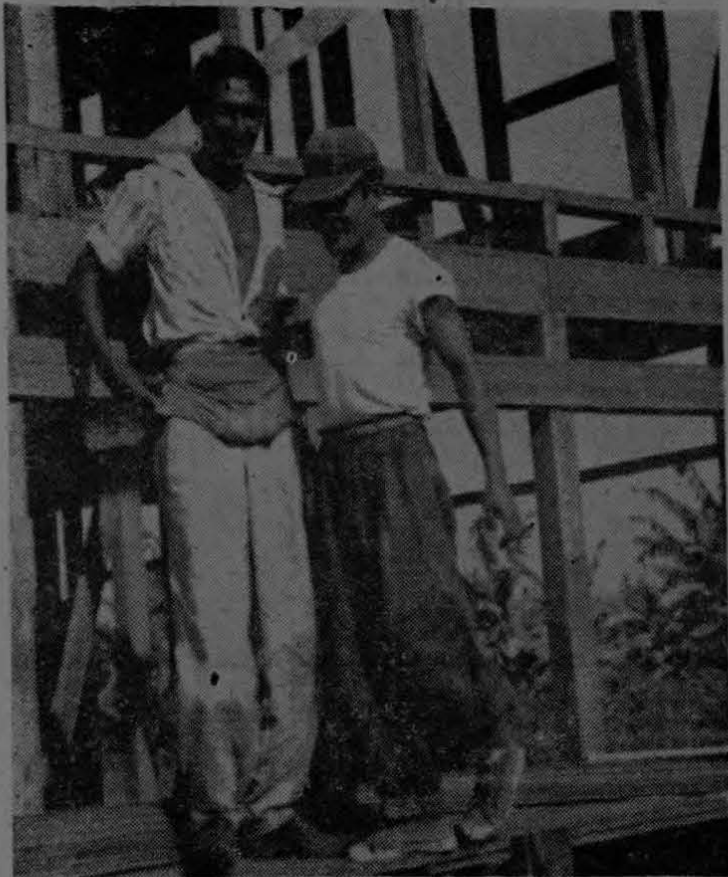
Joaquín Carrillo y Alvaro Sánchez fueron sorprendidos por la Cámara de EL PACIFICO en momentos en que trabajaban sobre los andamios de una de las muchas casas últimamente construidas en Coto 52. Esforzados, empeñosos, sienten la alegría de trabajar.
