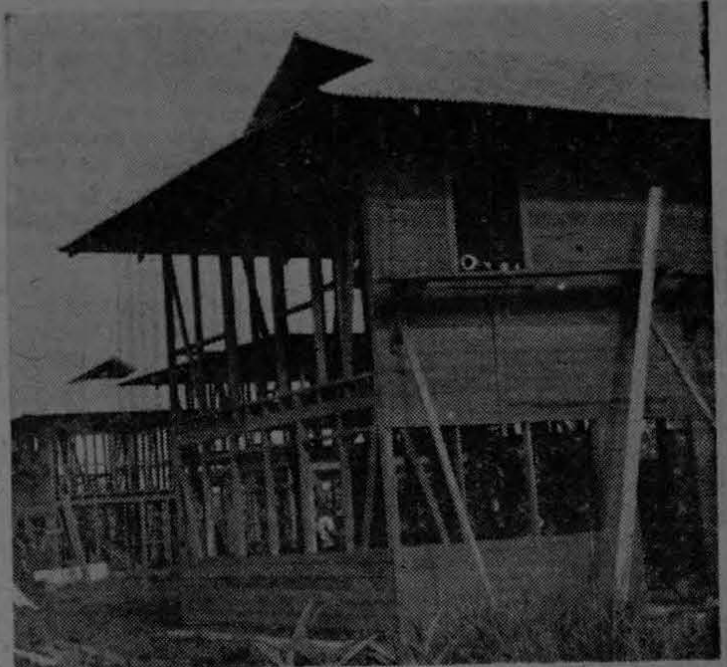
A principios de mes se hallaban en pleno proceso de construcción seis casas para foremen en Coto 52. Al salir esta edición, ya esas viviendas están terminadas. Se trabaja apenas en pequeños detalles para que sean habitadas.
