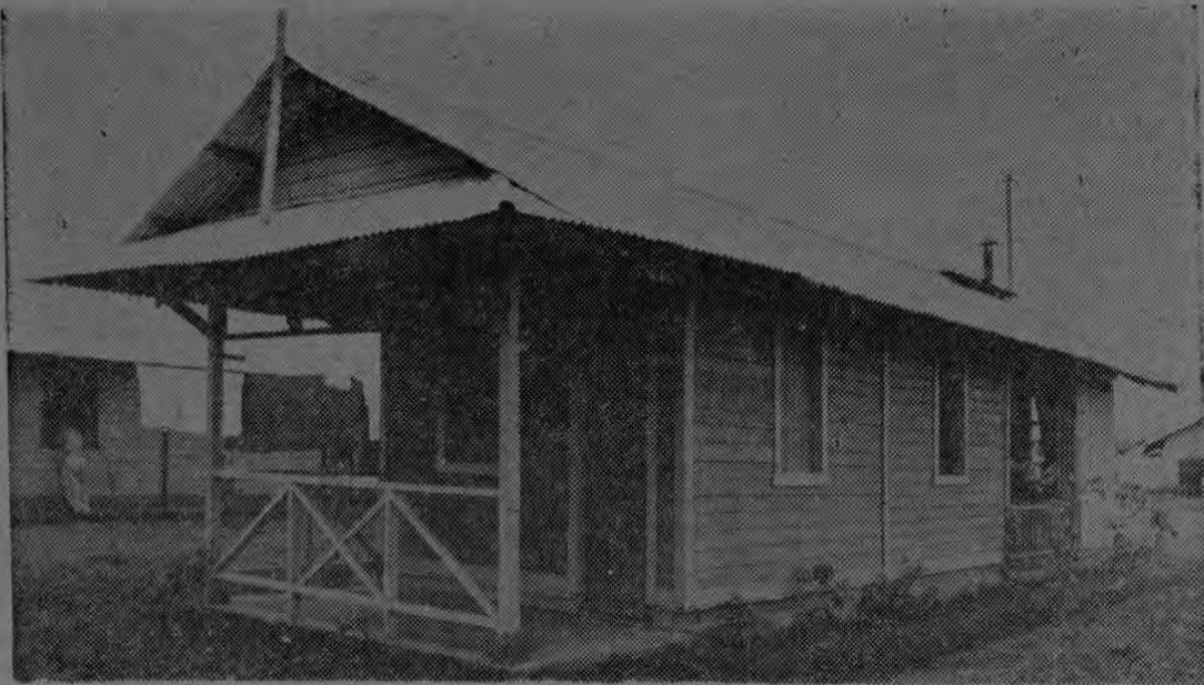
He aquí una de las casitas unifamiliares construidas en las fincas "Modelo" del Valle de Coto. — (Vista de frente).
