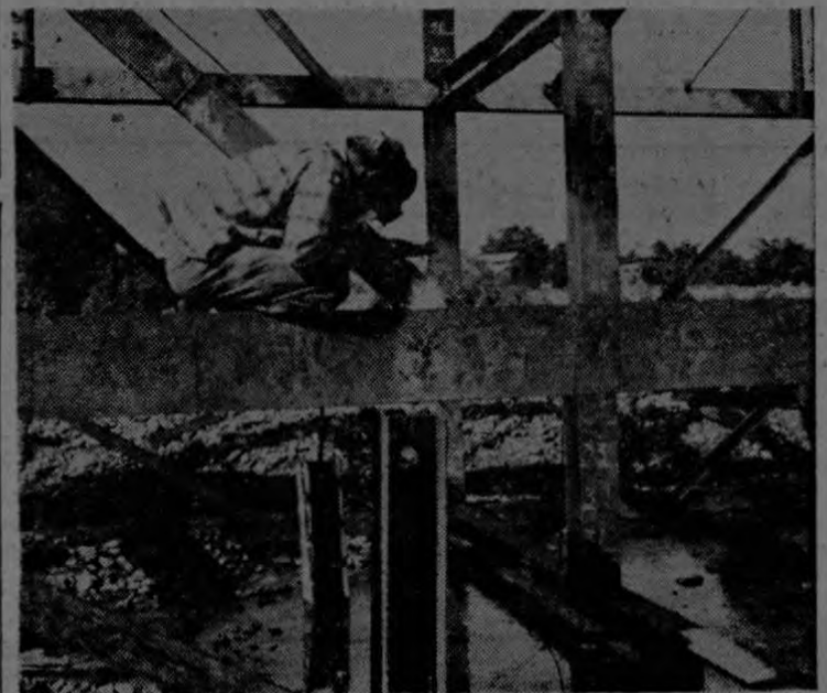
Un trabajador labora activamente en la soldadura de la monumental estructura de acero del magnífico puente que se está construyendo sobre el Rio Terraba, como parte integral del plan de la Carretera Interamericana en la región Sur del país.
