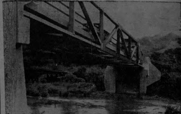
Vista del puente sobre el Río Pacuare, en el camino a Dominical. Fue construido con aporte económico del Consejo Nacional de Producción y en el plan cooperativo con el Ministerio de Obras Públicas, Municipios y Juntas Cantonales de Caminos.
