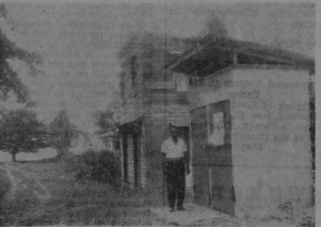
Este es el edificio de correos y la cárcel del lugar. Al lado, aparece el Agente Principal de Policía, Mr. Sinclair. Obsérvese el mal estado de las construcciones y la incomodidad total del edificio de Correos que, además, no tiene puertas seguras. El señor Agente de Policía debe andar con las cartas en la bolsa de su pantalón.
