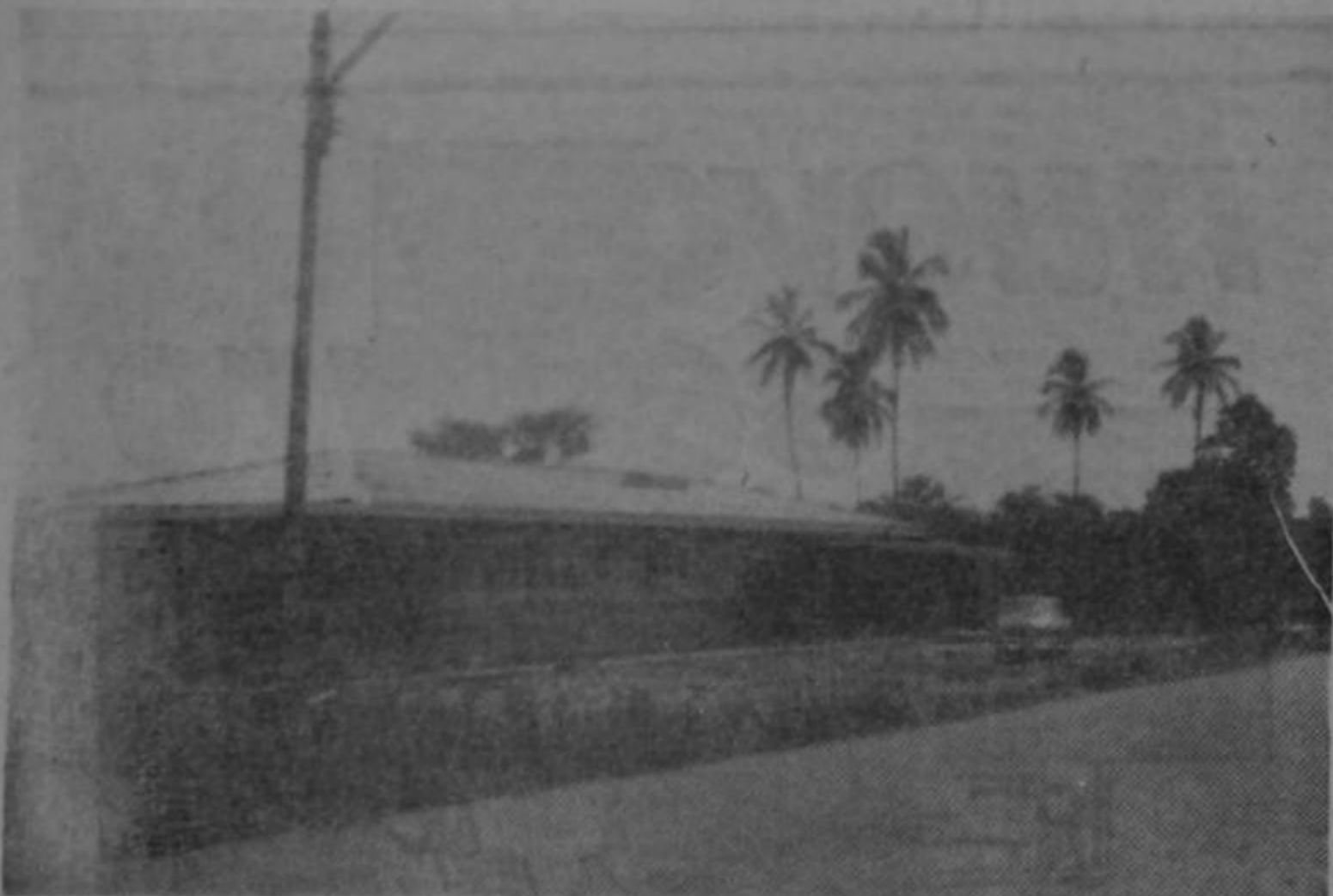
ASILO DE ANCIANOS EN PUERTO LIMON. Obra de bastas proyecciones sociales y de notable sentido humano. Aun no está concluido
