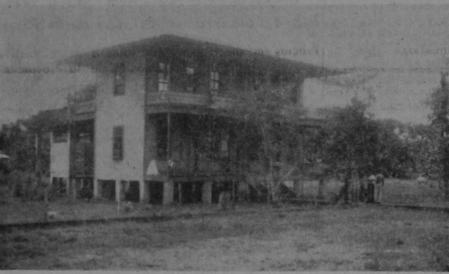
ESCUELA DE MATINA. Este edificio es, sin duda, el más atractivo de toda la población. Nótese que está montado en basas de cemento, resistentes, capaces de sostener el peso de tanto niño que asiste a ella en busca de una educación más sólida para un futuro mejor. Para acercarse a ella hay que caminar sobre un trillo de cemento, muy angosto y deficiente. Cuando llueve, lo que parece un encajetado se convierte en un suampo intrasitable.
