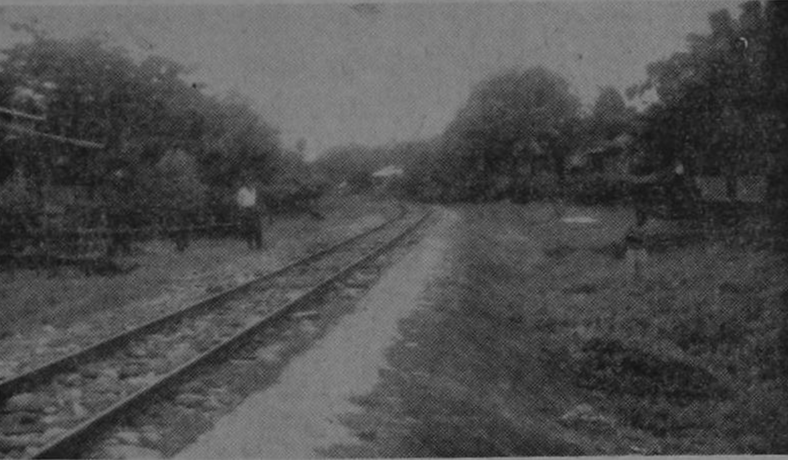
En uno de los costados de la vía férrea hay este repello de cemento. Se extiende hasta unos seiscientos metros y desemboca en el riachuelo, hacia el Oeste de la población. Esta pared cementada ha provocado serios conflictos con las aguas, que ahora no fluyen sino que se meten en toda la población de Matina. Los vecinos temen un desenlace fatal para fines de este año.
