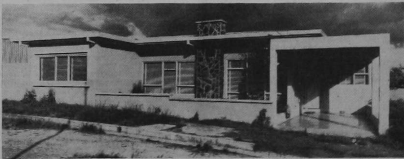
Casa construida por don Enrique Ramirez en Heredia con un préstamo del I.N.V.U. mediante las facilidades de su novedoso Sistema de Ahorro y Préstamo. El I. N. V. U. da préstamos de ₡ 2.000 a ₡ 50.000 en plazos de 1 a 10 años de ahorro. Pida informes al Teléfono 7052. Las cuotas de Ahorro y Préstamo pueden cancelarse en las oficinas bancarias de la ciudad.
