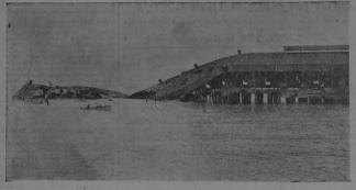
Esta vista representa el estado en que quedó el muelle después del hundimiento de la parte extrema, accidente do a las 11 y media de la noche del 13 del corriente. 1.—Lugar donde estaba atracado el vapor «Esparta», cuyos golpes contripuyeron al hundimiento. 2.—Lugar donde estaba la caseta que servía de dormitorio 4 los guardianes que cayeron al agua.
