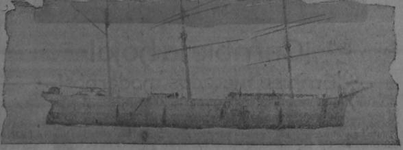
El Buque es de acero con 2 mástiles del mismo metal, puede cargar aproximadamente 1,600 toneladas no hace ninguna agua y se halla en buenas condiciones para la navegación. Posee además un Donky á vapor y centrífuga. La sola avería consiste en tener la quilla doblada en el centro con desviación de un pie sobre una extensión de 12 pies en dirección de popa á proa.
