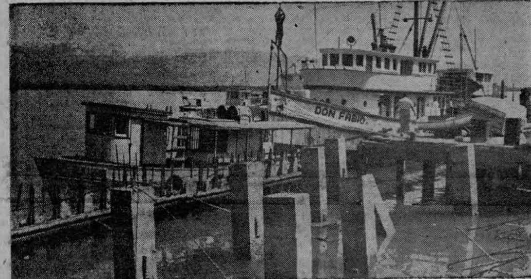
El "Don Fabio" es un barco de 330 toneladas que debe atracar, como vemos en la fotografía, junto a un montón de pilotes en acción de hundirse para siempre al par de podridas estructuras de muelle. Junto a él aparece la "San Lucas" y la "Centro América" de 150 toneladas. Todas estas naves están en constante peligro.
