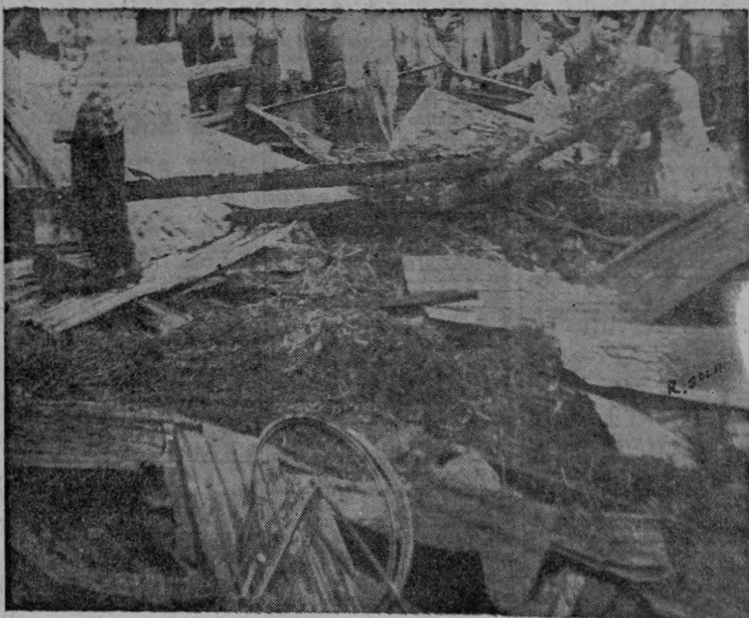
Aspecto parcial de la destrucción causada por el siniestro.
