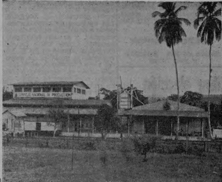
Vista del exterior de las instalaciones. En la Secadora se recibe el maíz comprado por el Consejo y se le somete a los procesos de secado, desgrane y embalaje, para ser enviado luego a los centros de consumo.
