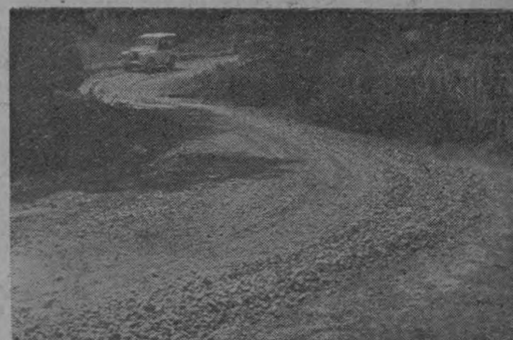
Curvas de la carretera entre San Pedro de Poás y Grecia donde la Junta de Protección a la Agricultura de la Caña ha realizado arreglos de la vía en más de doscientos metros. Asimismo, reconstrucción del paso Río Tacares y del puente.
