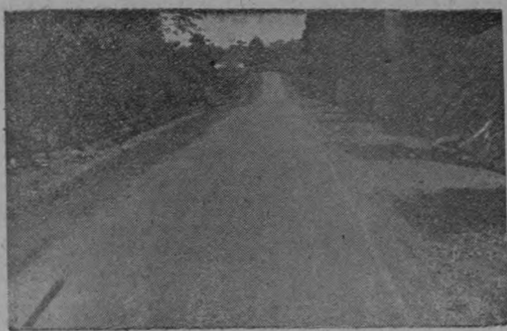
Un aspecto de la excelente carretera a San Isidro que facilita el acarreo y entrega de caña de numerosos productores a los ingenios de Grecia. Estas vías de comunicación se mantienen en muy buenas condiciones en virtud de la vigilancia y control de la Junta de Protección a la Agricultura de la Caña.
