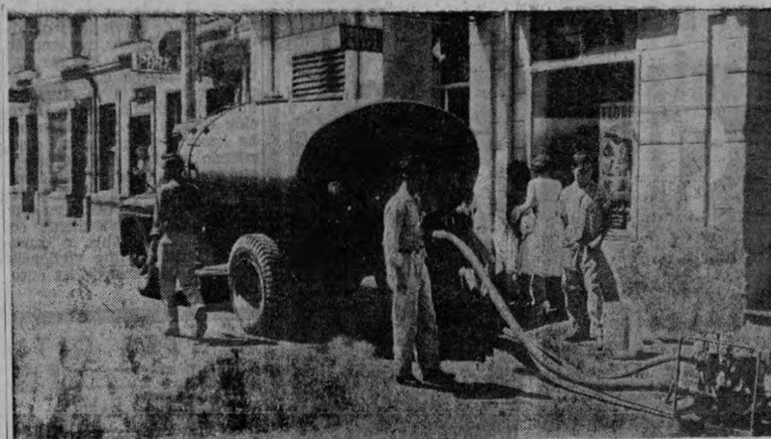
Momento en que se "inyectaba" agua potable a los tanques o estaciones de una residencia, frente al Parque Central, en la mañana de hoy
