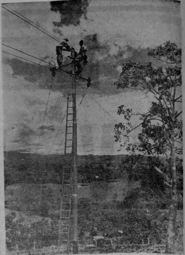
Operarios del ICE realizan las conexiones finales en el poste N° 20 de la línea El Descanso-Grecia
