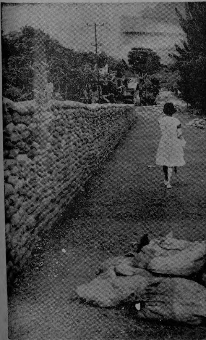
MURALLAS EN TRES RIOS. — Murallas de sacos con piedra molida han sido construidas para defender a Tres Ríos de los vaivenes del Tiribí en el invierno. Cientos de metros de muralla marcan ahora las zonas de peligro en esta ciudad.
