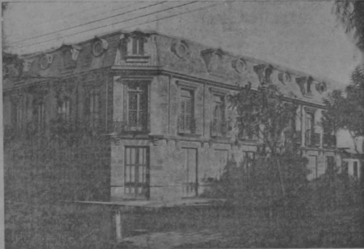
EDIFICIO DE «LA ARENA»
