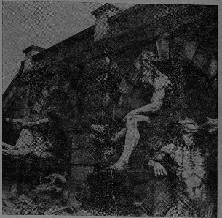
Fuente denominada "La Corte de Neptuno" en el edificio de la Biblioteca del Congreso. (Foto Jorge Lines)
