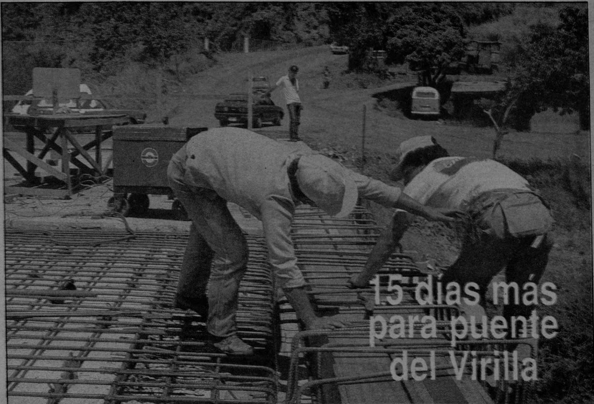
Los trabajos de ampliación del puente sobre el río Virilla, no estarán listos en la fecha prevista, ayer se preparaba el trabajo para la chorroca de la losa, que podría tardar como mínimo de 12 a 15 días para adquirir la resistencia adecuada. Los trabajos se iniciaron el 18 de abril. (Villegas)
