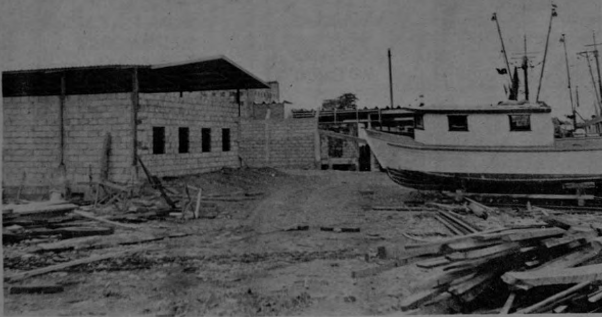
La escuela de construcción naval en construcción. Pronto la terminarán.
