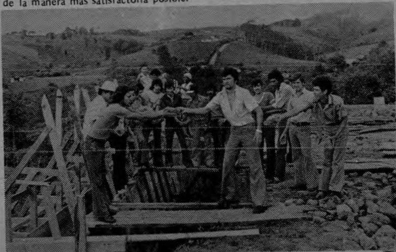
Construyen un muro de contención en la plaza deportiva
