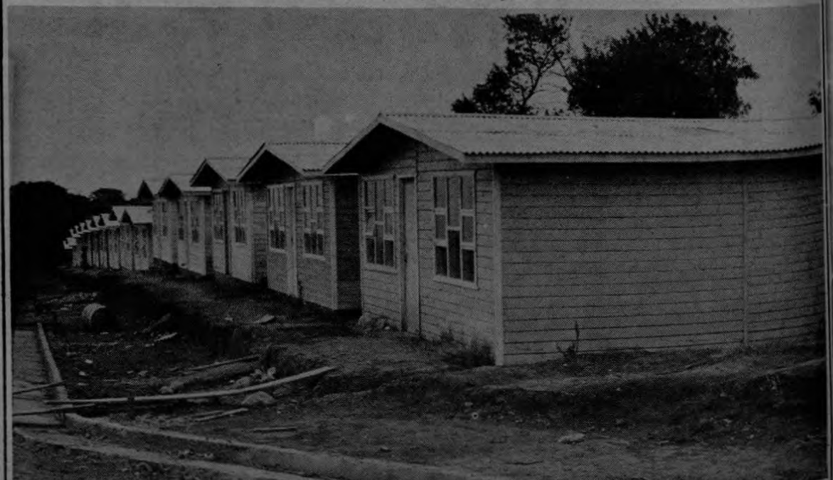
En la fotografía se aprecia un grupo de viviendas construidas con préstamos del Banco Popular. El ente bancario hace grandes esfuerzos a favor de la construcción de viviendas populares en el país.
