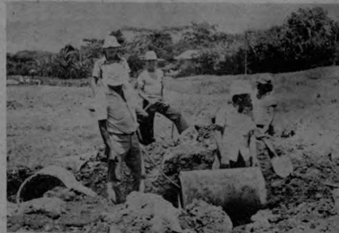
Un grupo de trabajadores de Turrialba realizando las labores de urbanización del futuro complejo de viviendas de "SICTAYA"
