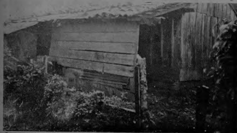
Esta "residencia" es una muestra del angustioso drama que viven cientos de familias en Cot de Cartago, donde el problema de la vivienda es uno de los más graves y cuya solución no se vislumbra aún.
