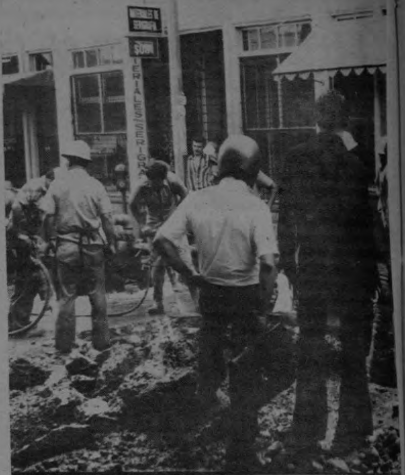
Al irrespeto de las regulaciones de tránsito, cada vez más generalizado, se añaden la desorganización del mismo y la total ausencia de planificación y orden en las reparaciones viales en San José.
