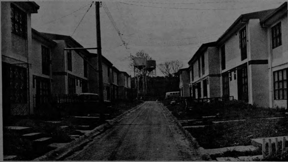
La Ley de Fraccionamiento Urbano dice una cosa, pero PROVISA hizo otra. Esta calle de La Aurora, sólo tiene 3.5 metros de ancho. Al fondo vemos los tanques de donde escapa, con mucha frecuencia, el agua en grandes cataratas dejando después a la ciudadanía en una completa sequía, todo por falta de mantenimiento de las plantas que accionan los respectivos pozos.
