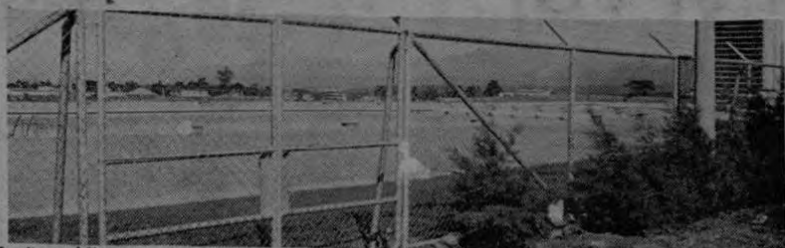
En la gráfica se observa el portón cerrado de las piscinas del complejo Deportivo "La Sabana", y al fondo las piscinas que no han podido ser puestas al servicio del público por haber detectado dos fugas de agua.
