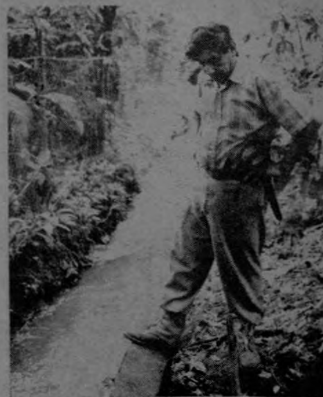
Antonio Solís, campesino de Tuetal Sur, muestra uno de los viejos canales de riego, que existen en el norte de Alajuela desde los años 40. El proyecto de Itiquís utilizará las mismas estructuras pero las mejorará técnicamente.
