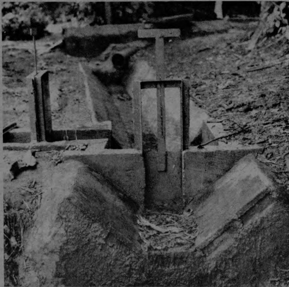
Las zanjas y los trillos serán sustituidos en el interior de las fincas por sistemas de canales y compuertas que permitirán un mejor aprovechamiento del agua, del tiempo y de la mano de obra.
