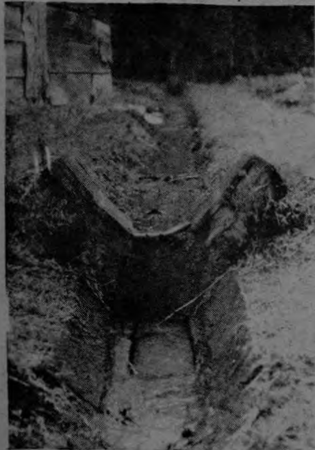
Salto o gradientes de cemento como éste, se construirán para evitar que el agua erosione los suelos dentro de las fincas. Los ingenieros explican que la única ciencia que requieren es la exactitud en las medidas, por lo que pronto los agricultores se acostumbrarán a construirlos ellos mismos.
