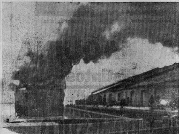
Este edificio destruido formó hace pocos días parte de la gran fábrica química de Monsanto, valorada en diecinueve millones de dólares. Esta foto tomada durante el día mientras densas columnas de humo se levantaban de las ruinas humeantes de la ciudad, convirtiendo el día en noche.
