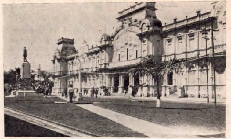
Central de Correos y Telégrafos, San José
