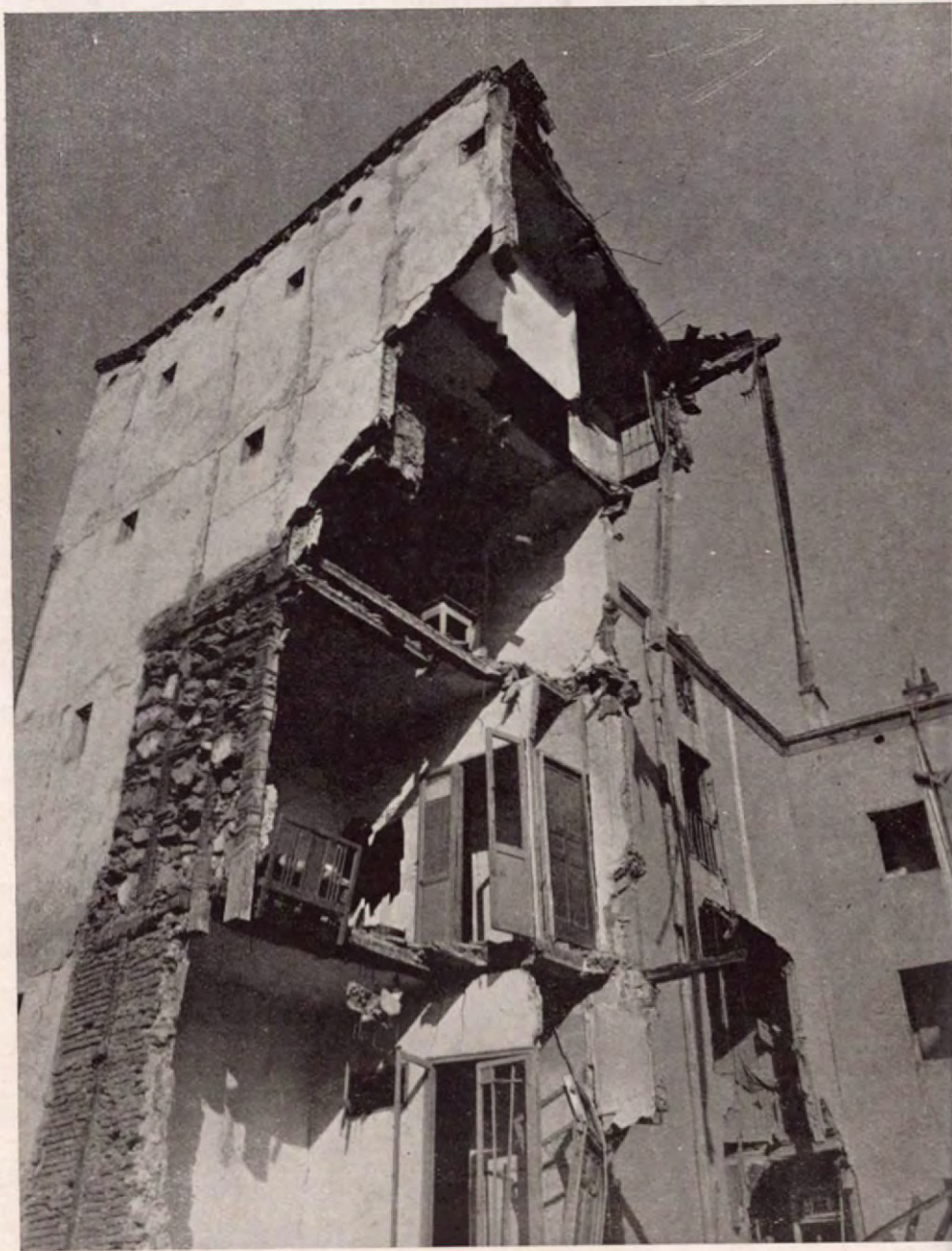
Otro edificio de Madrid, en la calle de la Ruda, destruido por los «civilizadores» de Hitler y de Mussolini.
