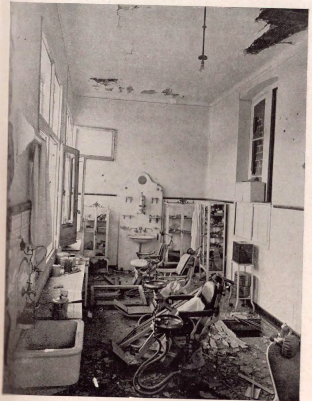
Un departamento del Hospital de San Carlos, parcialmente destruido por bombas incendiarias de los aviones fascistas.
