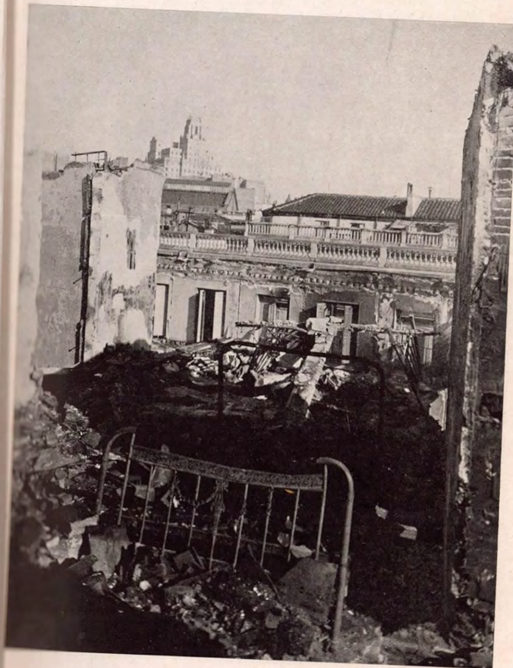
Otra casa destruida en la Puerta del Sol por aviadores de Berlín y de Roma.
