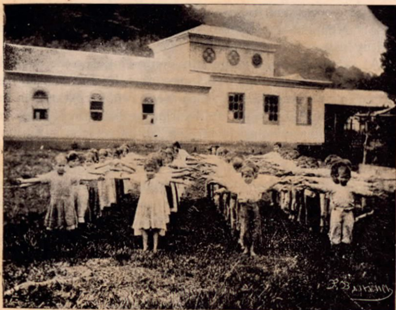
Ensayo de flexiones en la escuela de Acosta
