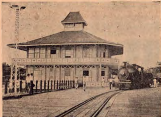
Casa del Administrador del Muelle en Puntarenas y entrada al mismo.
