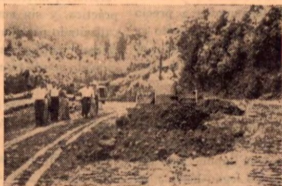
TRABAJO DE REPARACION DE CAMINOS
