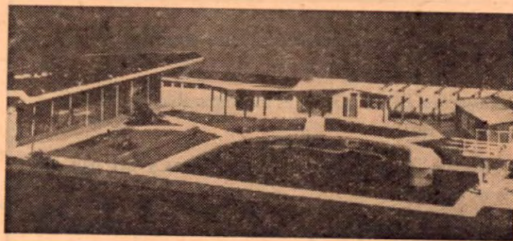
Réplica del edificio del Balneario en construcción en Turrialba
