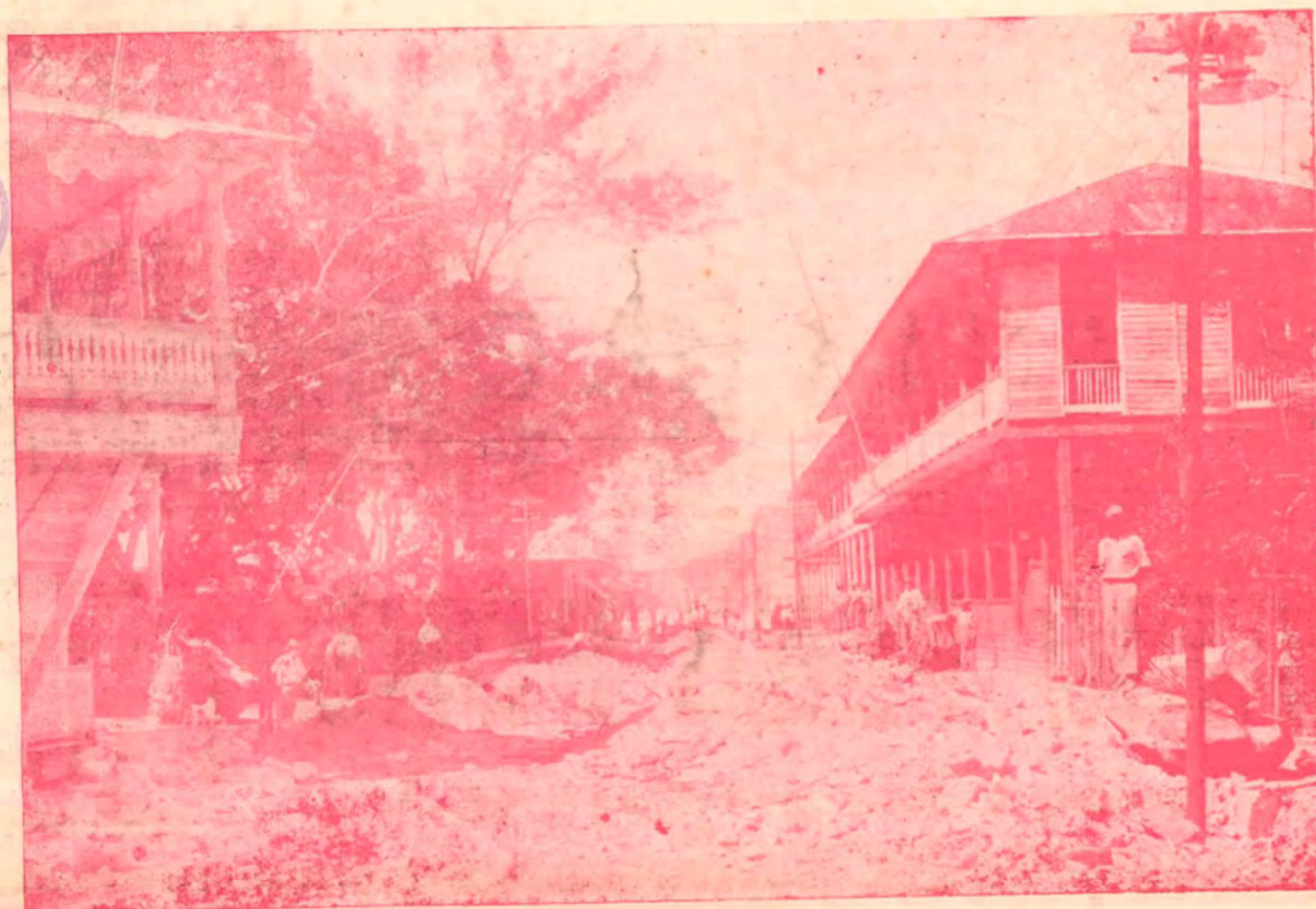
Aspecto interesante de hace unos treinta años, de los trabajos de pavimentación de las calles en Limón
