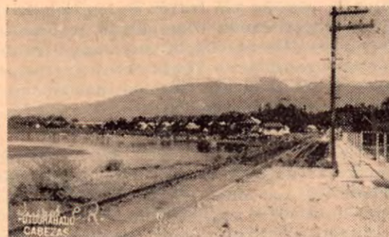
EL PUENTE DE BOCA VIEJA EN EL PUERTO DE QUEPOS
