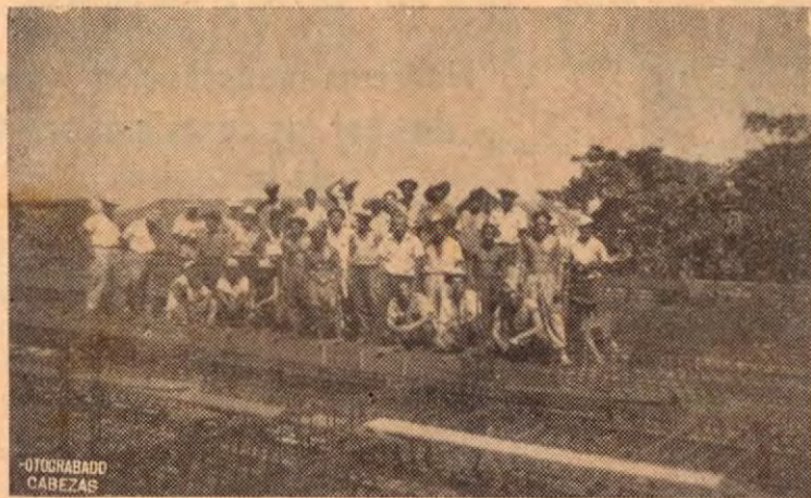
Grupo de trabajadores de la construcción
