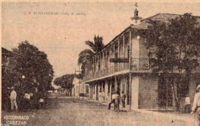
La antigua calle Fiedra ahora Francisco de Paula Amador está siendo macadamizada
