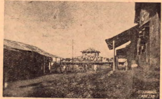
Una calle en Miramar, al fondo el mercado en ruinas
