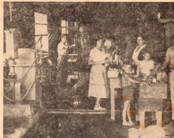
Pabellón de la maquinaria en el interior de la fábrica
