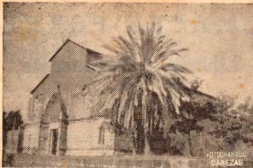
IGLESIA DE LIBERIA que desde hace muchos años está en construcción
