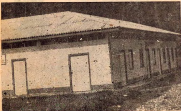
La gráfica recoge un aspecto del edificio en donde se halla instalada la Agencia del Banco Nacional de Costa Rica en Villa Neily.
