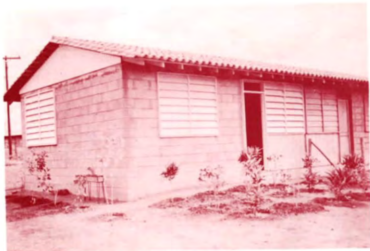
Vivienda de la unidad vecinal "NICARAO" — Managua
