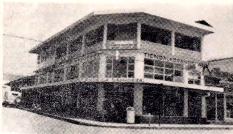
Moderno edificio del Almacén "La Grandeza" en el centro de San Isidro de Pérez Zeledón.
