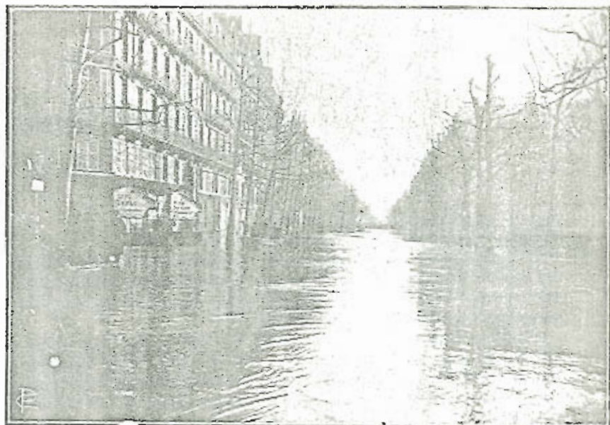
Vista de la inundación del Boulevard Haussmann, ocasionada por la rotura de la alcantarilla que figura en nuestro grabado anterior.
