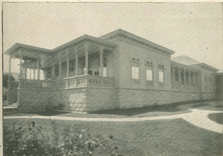
San José, Costa Rica — Pabellón Bansen en el Asilo Chapuí
