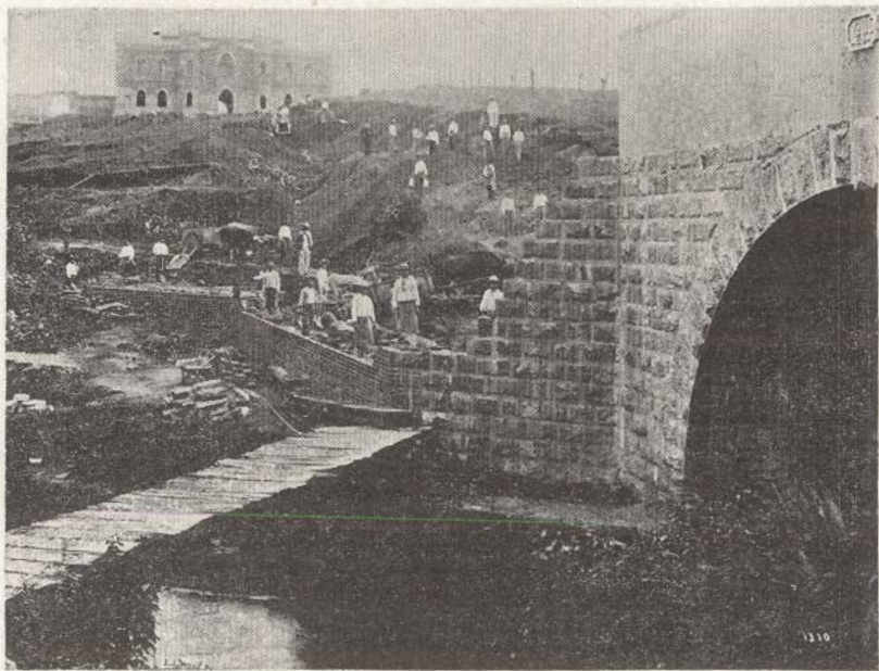
San José, Costa Rica. — Trabajos en la calle que conduce á la Cárcel Nueva
