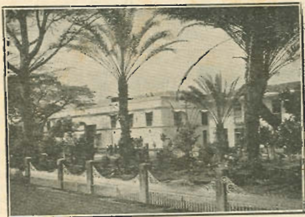
Vista del Cuartel Principal
