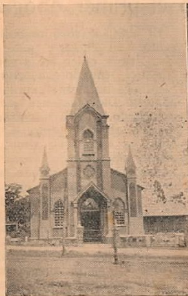
Fachada de la Iglesia de Cot
