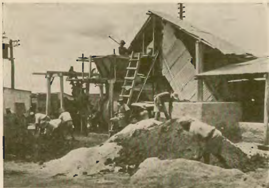
FIG. 4. Preparando desperdicios urbanos en Nairobi.
